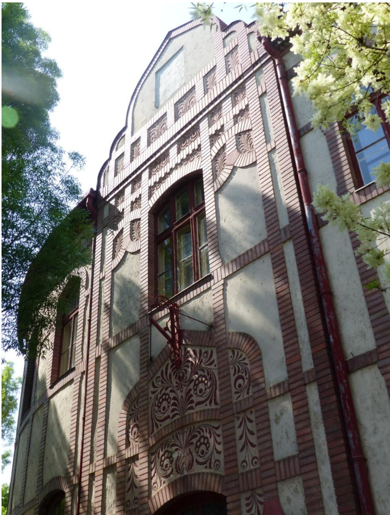
A téglá és sgraffittó-vakolat együttes alkalmazása a gyulai szecesszió kedvelt homlokzatképzési technikája.
