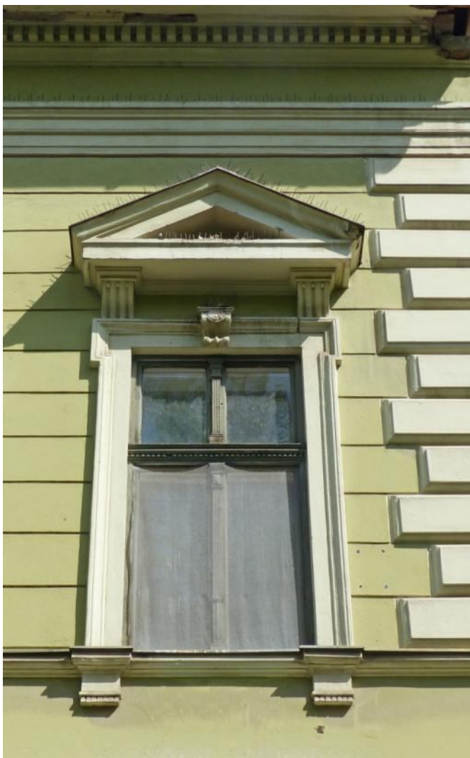
Eklektikus tagozatok utcával párhuzamos tömegű házon. Az épülettagezatok minél plasztikusabb megformálása gyakorlati jelentőséggel is bírt. Az erősen kiülő szemöldökpárkány esztétikai szerepe mellett a csapóesőtől is védte az alatta elhelyezkedő nyílászáró szerkezetet.
