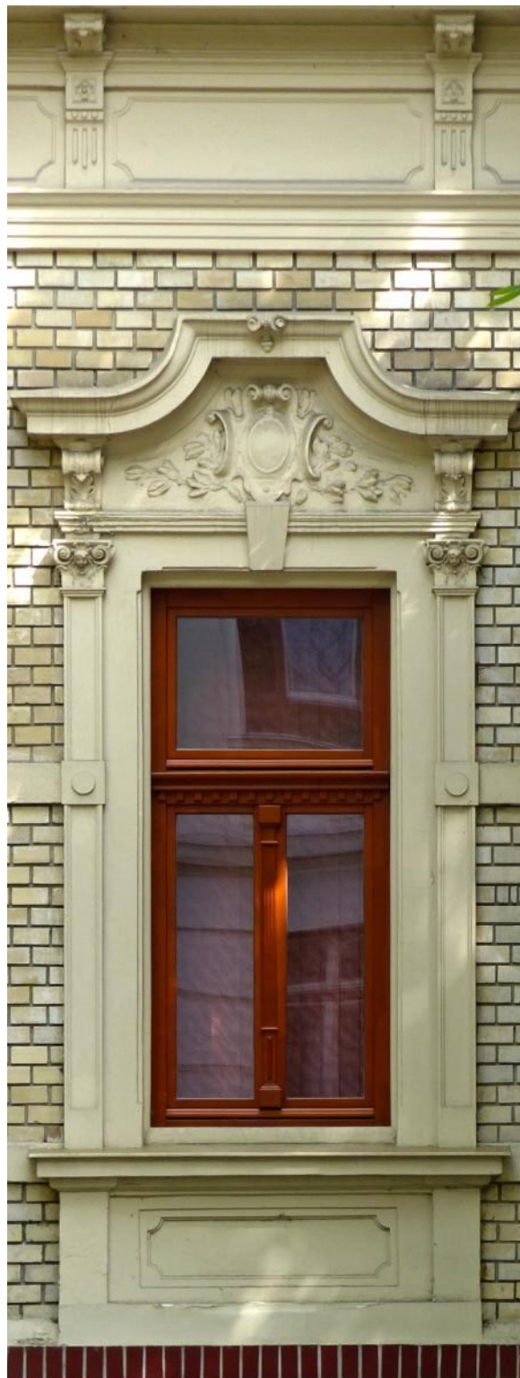
Eklektikus tagozatok utcával párhuzamos tömegű házon. Az épülettagezatok minél plasztikusabb megformálása gyakorlati jelentőséggel is bírt. Az erősen kiülő szemöldökpárkány esztétikai szerepe mellett a csapóesőtől is védte az alatta elhelyezkedő nyílászáró szerkezetet.
